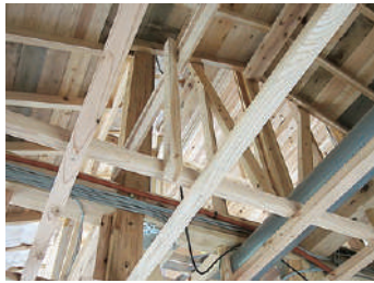
天井野縁を組んだ状態
