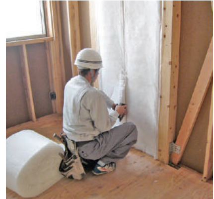
両端を押し込み過ぎた状態で46%の性能しか出ない。
