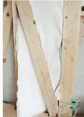
断熱材を筋交いの裏側に入れます。
