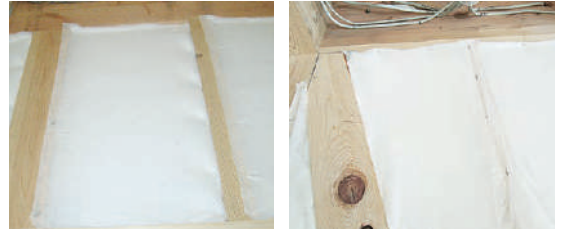
上枠に垂れ下らないようにタッカ留め(150mm間隔)
