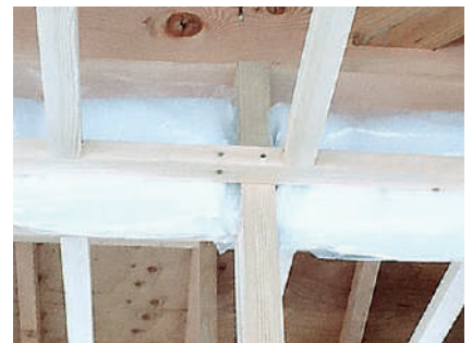
d) 防湿フィルム付き断熱材により気流止め (4地域以南)
