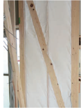
筋交いの両側に沿って、マット厚み半分ほどの切り込みを入れ、マットと筋交いが同面になるようにタッカー留めします。
