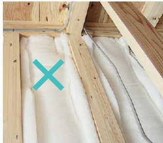
両端を押し込み過ぎた状態で46%の性能しか出ない。
