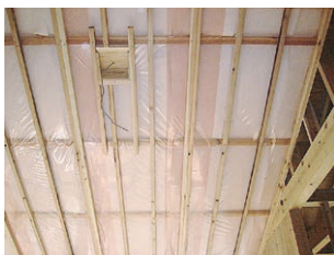
断熱材の下に防湿フィルムを施工します。
