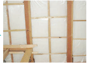
野縁の下に防湿フィルムを施工します。
