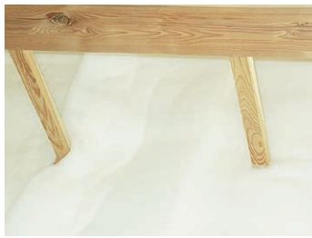
吊り木廻りの断熱材を切ります。
